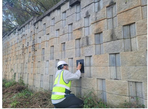
경사계를 이용한 경사도 측정사진
