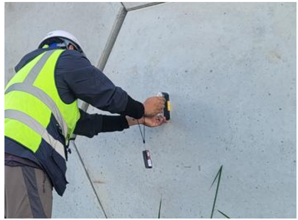
경사계를 이용한 경사도 측정사진
