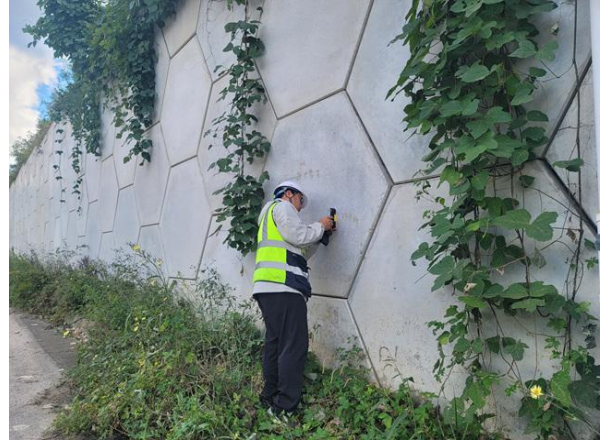
경사계를 이용한 경사도 측정사진
