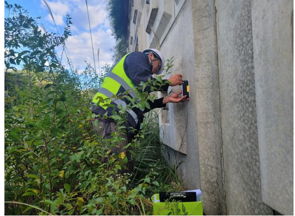
경사계를 이용한 경사도 측정사진
