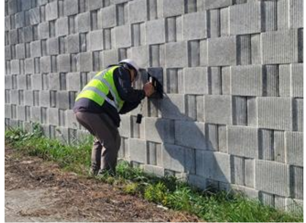
경사계를 이용한 경사도 측정사진
