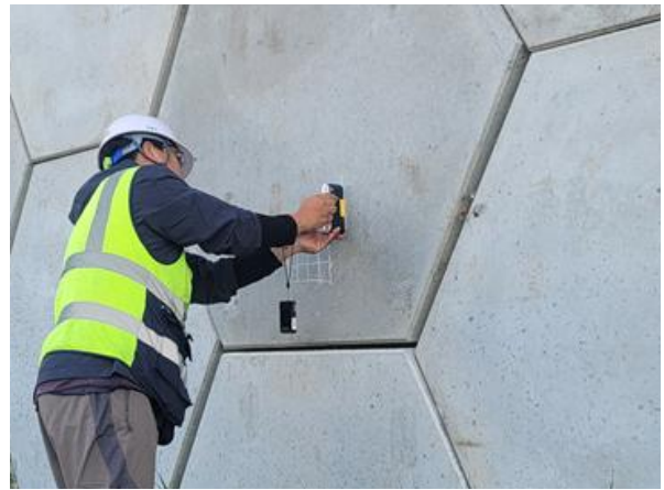
경사계를 이용한 경사도 측정사진
