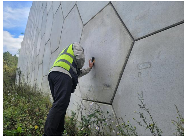
경사계를 이용한 경사도 측정사진
