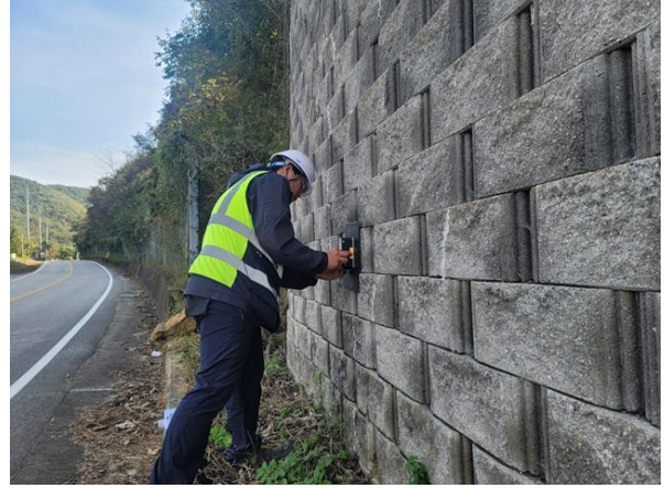
경사계를 이용한 경사도 측정사진
