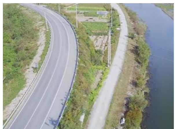
상부 성토부 전경
