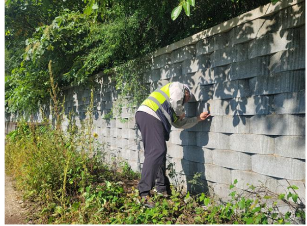
경사계를 이용한 경사도 측정사진
