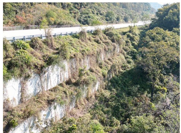
상부 성토부 전경
