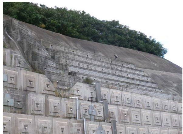
배수관, 배수로 전경
