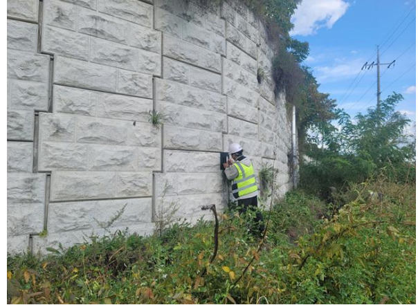
경사계를 이용한 경사도 측정사진
