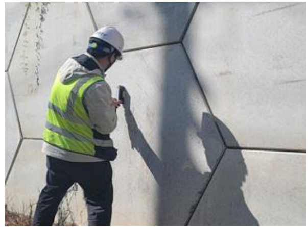
경사계를 이용한 경사도 측정사진
