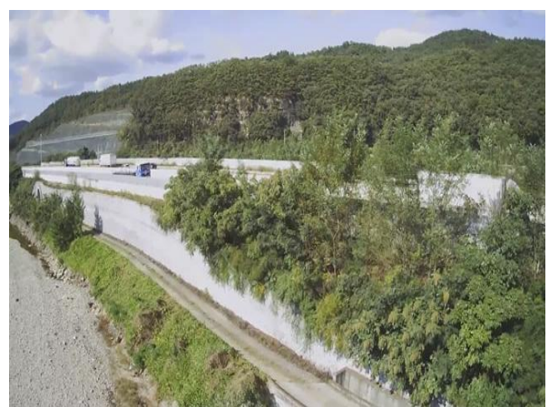
상부 성토부 전경
