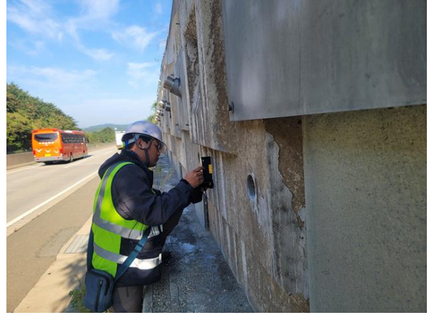
경사계를 이용한 경사도 측정사진
